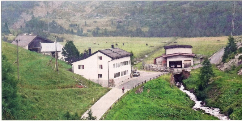
So präsentieren sich die Alpbauwerke oberhalb Breda der Alp Crap alv der ETH im Überblick.
