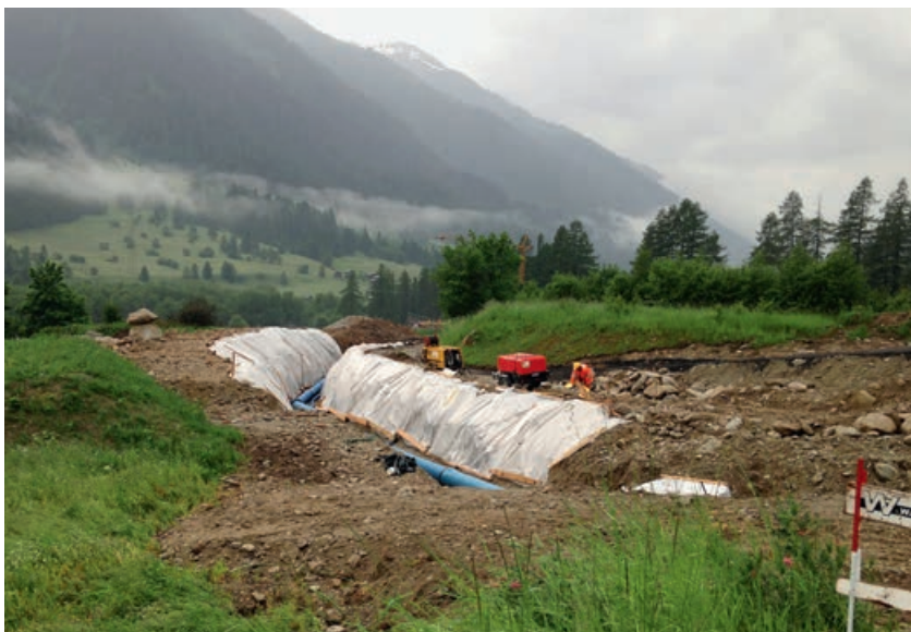
Abb 4 Kleinwasserkraftwerke stehen im Spannungsfeld zwischen der Produktion erneuerbarer Energie und dem Landschaftsschutz. Auf dem Bild der Bau eines Kleinwasserkraftwerkes am Walibach im Goms (Wallis). Foto: WWF Wallis
