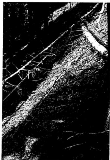
Diagonal verankerte Stämme, die Naturverjüngung und Kulturen vor Schneegleiten schützen sollen, mit darunterliegenden Bermen für eine Stützpunktpflanzung
