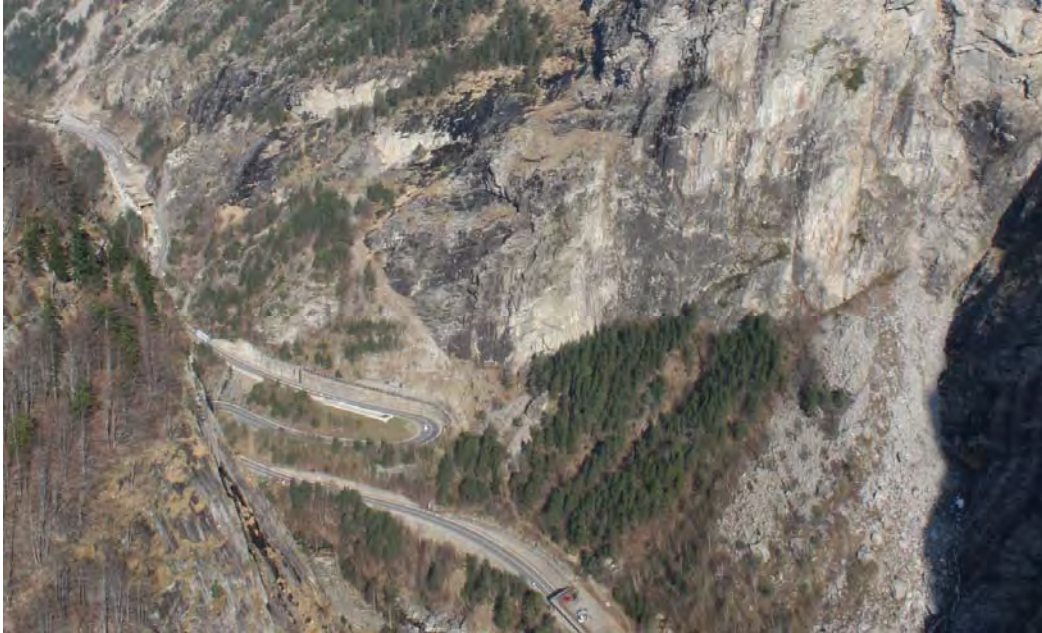
Schutzwald ob der Simplonstrasse. Foto: 18.4.2013/F2
