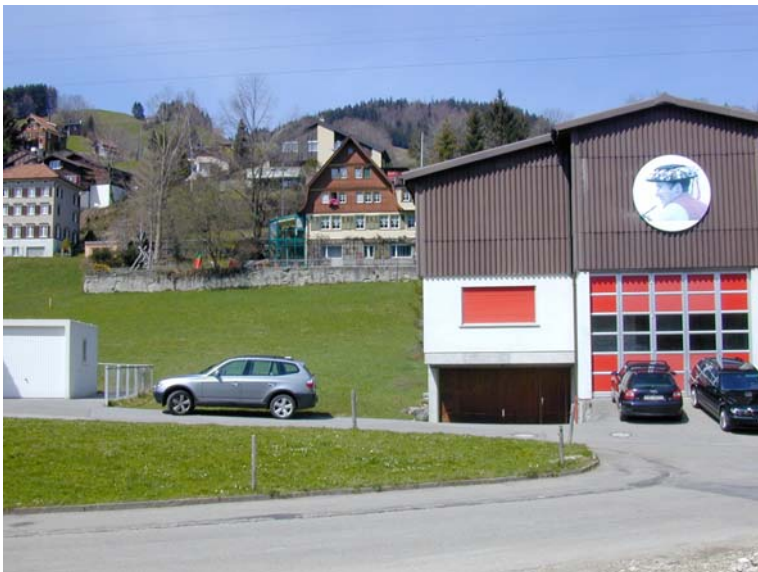
Abbildung B5: Lagerhalle der Dörig AG, Käsehandel. Links davon Parzelle für geplanten Erweiterungsbau.
