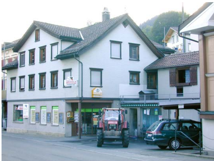
Abbildung A1: Milchsammelstelle Urnäsch Dorf mit Vorplatz für Milchumschlag, aktuelle Situation.
