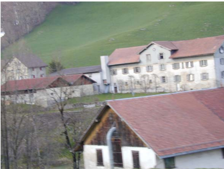
Abbildung B4: Ehemalige Käserei Zürchersmühle (Hintergrund) mit zugehörigen Schweinemastställen (links im Bild).
