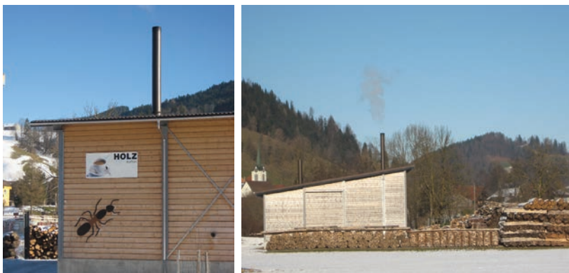
Abbildung 2 Die Holzbohleheizung in Urnäsch (Fotos: ETH-UNS TdLab)
